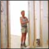
Typ AL 2L: Kontrolowanie słupa ściany.
