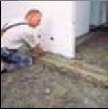
Typ AL 2L-2G: Wyrównywanie materiału jastrycha.
