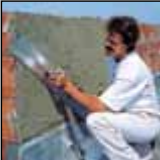
Typ HAK: Wygladzanie powierzchni obrzutki.
